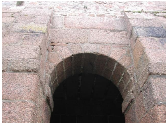
Vue en contre-plongée de la poterne aval en plein cintre avec ses contreforts.
